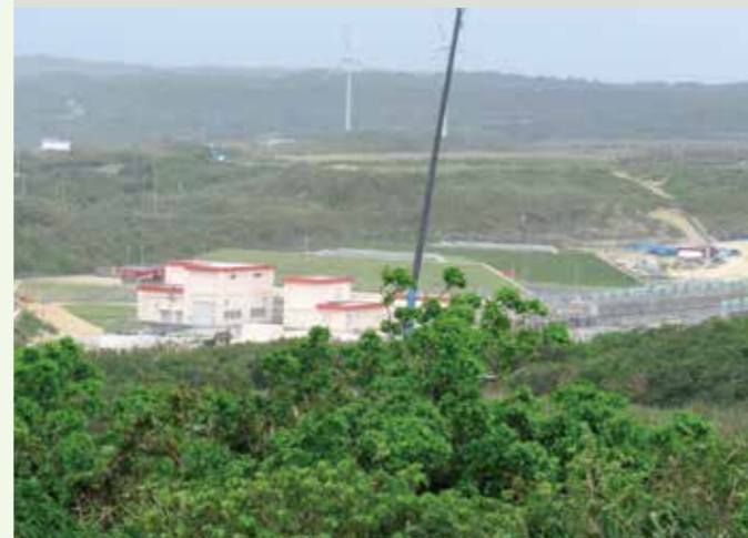
◀建設が進む宮古島・保良(ぼら)弾薬庫
