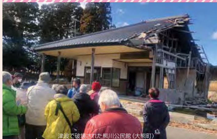
津波で破壊された熊川公民館（大熊町）
